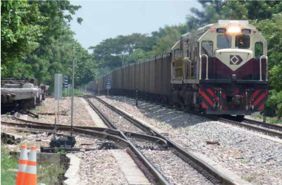
La línea férrea que transporta el carbón desde las concesiones mineras en el Cesar hasta los puertos marítimos en la Costa Caribe.
