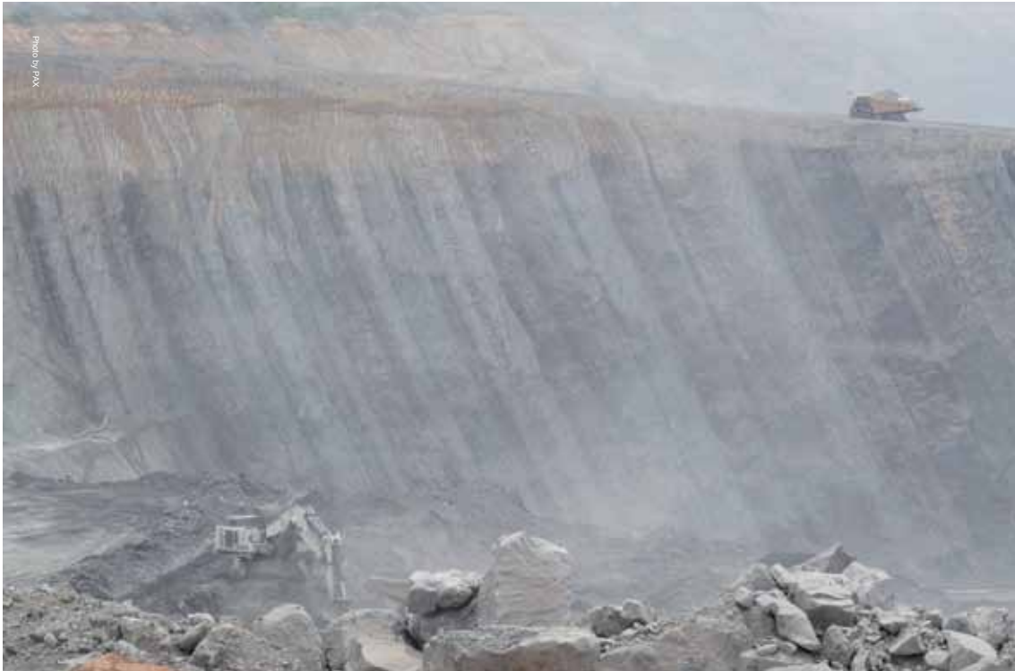
Taludes escarpados de la mina de carbón a cielo abierto de Drummond, en La Loma, región central del departamento del Cesar.
