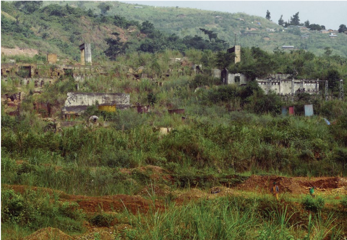
Ce qu'il reste aujourd'hui des mines belges : les anciennes structures des mines et les tailings (au premier plan) - les sable aurifère qui tient un résidu d'or
