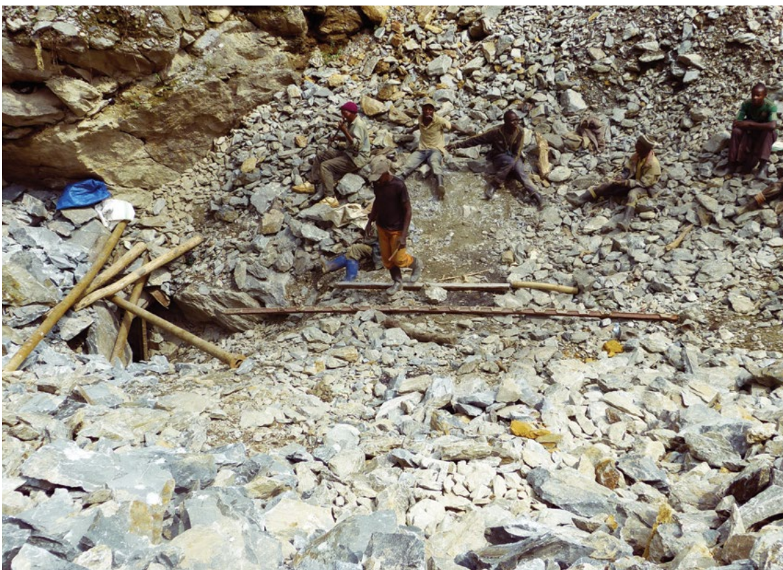
Travail pénible et dangereux dans les mines artisanales sous-terraines ; ici : l'entrée de la mine de Senzere
